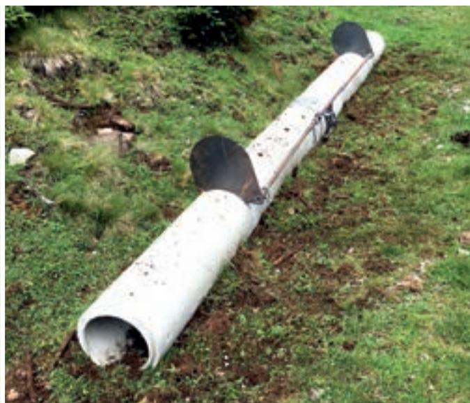
Nun werden die Fallbleche im ausgelösten Zustand mit dem Auslöser über ein Gestänge verbunden und montiert. Anschließend die Falle scharf stellen und kontrollieren, dass sich die Bleche noch zwischen den Rohren, aber nicht im Rohr befinden. Jetzt teste ich die Falle einige Male, funktioniert sie reibungslos, werden die Rohre noch von allen Seiten mit Erde, Steinen und der vorher entfernten Grasnarbe stabilisiert und fixiert.
