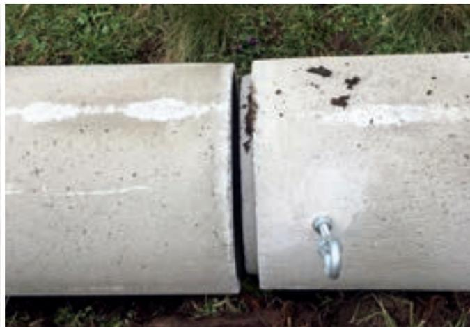
Beim Legen der Endrohre muss nun ein geringer Abstand (ca. ein bis zwei Zentimeter) eingehalten werden, der oben und unten gleich sein sollte. Nur dann fallen die Bleche leicht zu und können sich nicht verkeilen. Die Eingänge müssen unbedingt auf Erdniveau sein, es darf keine Stufe entstehen. Hier zeigt sich nun, ob die Rohre sauber ausgerichtet wurden. Ansonsten muss nachjustiert werden.
