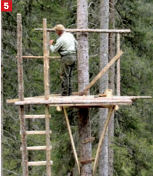
**Abb. 5)** Die Steher (Vorderseite 1,8 m, Hinterseite 1,7 m) und Dachsparren (ca. 2,5 m) länge ich mir am Boden ab und befestige diese am Boden. Um die Säulen gerade anbringen zu können, verstrebt man diese mit Brettern an der Innenseite. Somit erhält man ein stabiles Grundgerüst.
